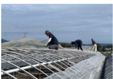
ビニール張り作業をする青年部員
