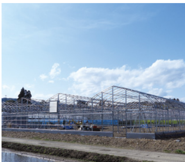
▲増設中の2号ハウス
