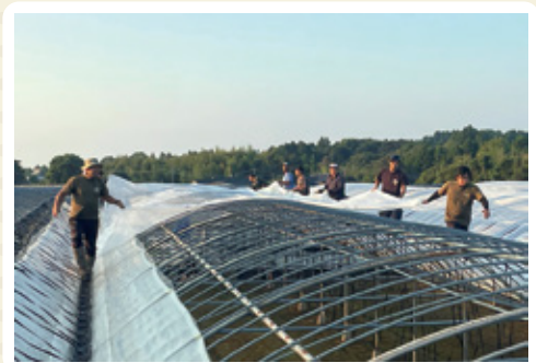
ビニール張り作業をする青年部員
